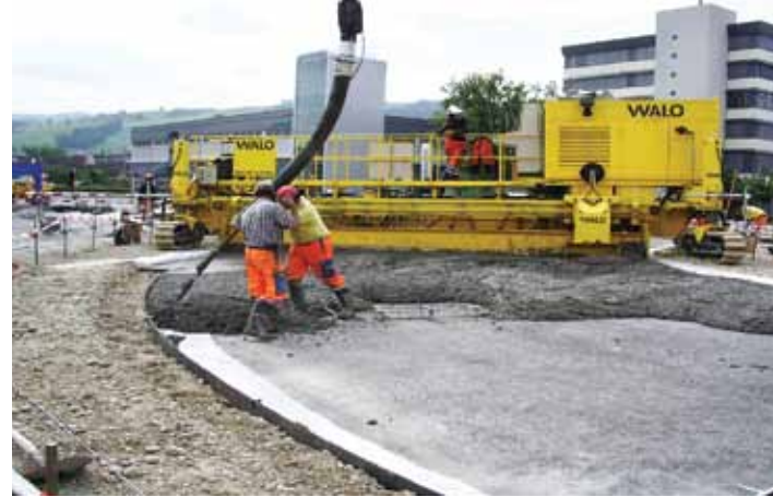
Izdelava betonskega vozišča s pomočjo vibracijskega valja
