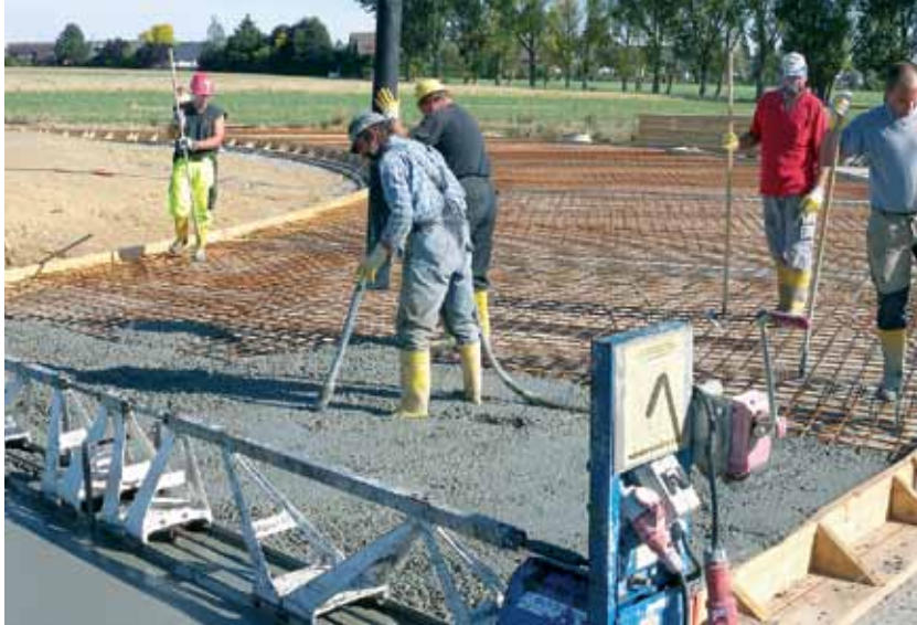
Armiranje betonskega krožišča in zgoščevanje betona z vibracijsko iglo Foto: Holcim Süddeutschland
