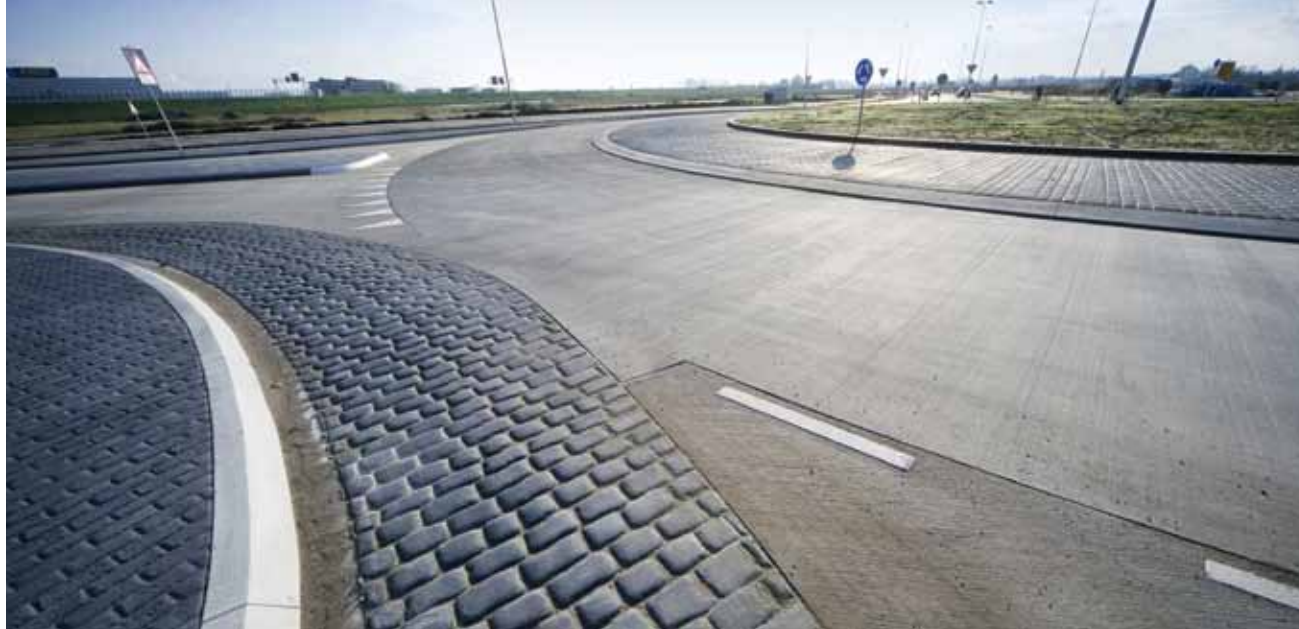
Primer uporabe robnikov na notranjem in zunanem robu krožišča
