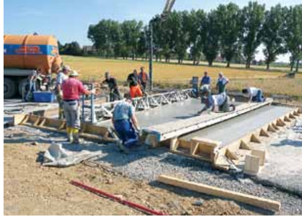
Betoniranje testnega polja, fiksni opaž je narejen iz močnih lesenih desk.
