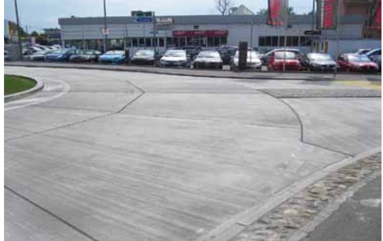
Robusten rob vozišča, izveden z uporabo kamenja
