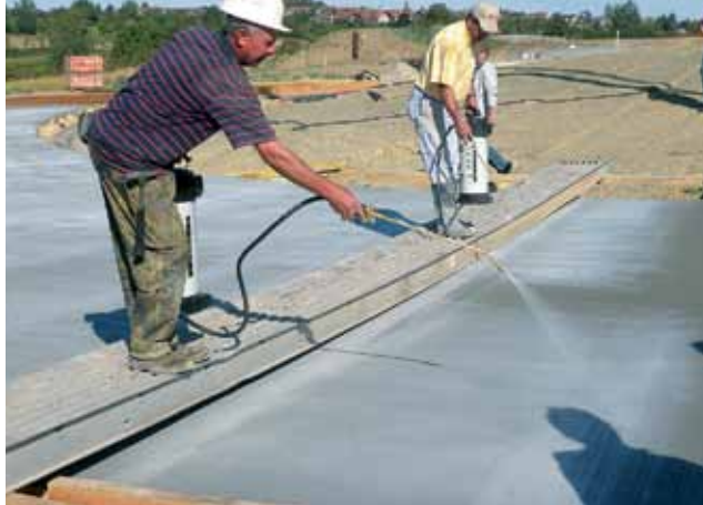
Nega betona s pobrizgom in prekrivanje s PVC folijo oziroma namočenim filcem
