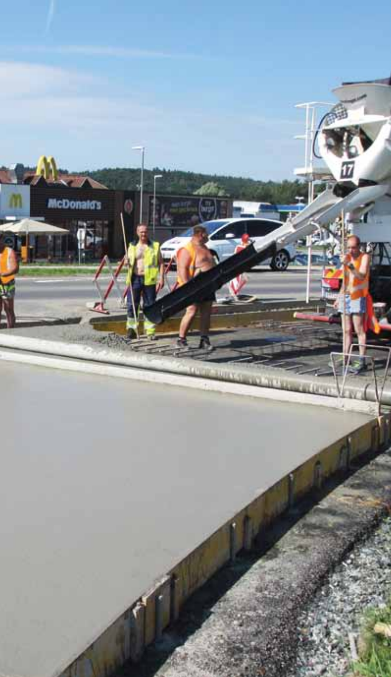
Izdelava betonskega vozišča s pomočjo vibracijskega valja
