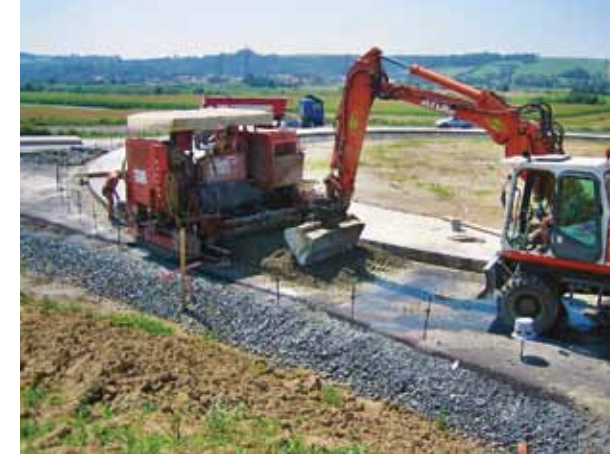
Betoniranje s finišejem omogoča delo na zelo široki površini.
